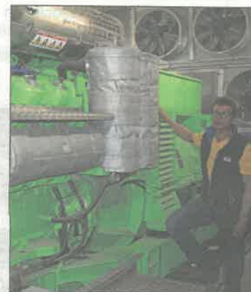
Pour réduire ses charges, l'exploitant utilise un moteur de cogénération de 5 000 chevaux.
